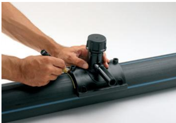
(Отметка маркером периметр седлового отвода)
