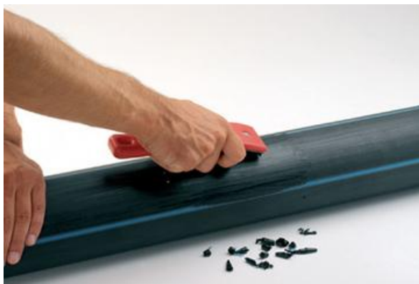
(Процесс снятия оксидного слоя с трубы)
