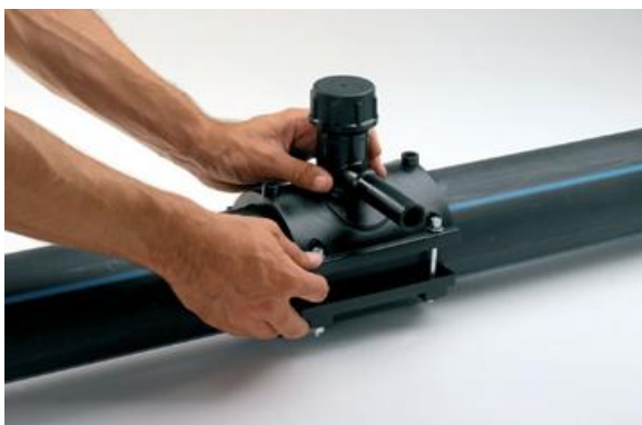
(Установка седлового отвода на трубу)
