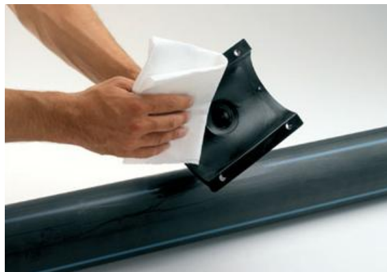
(Обезжиривание седлового отвода и трубы)
